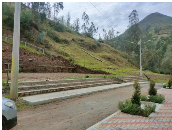
Fotografía 16 Espacio recreacional Manzanapamba
