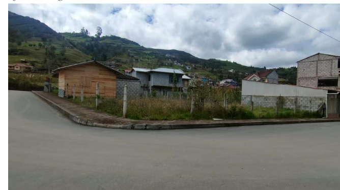
Fotografía 4 Reserva de predio Plaza Artesanal afección generada
